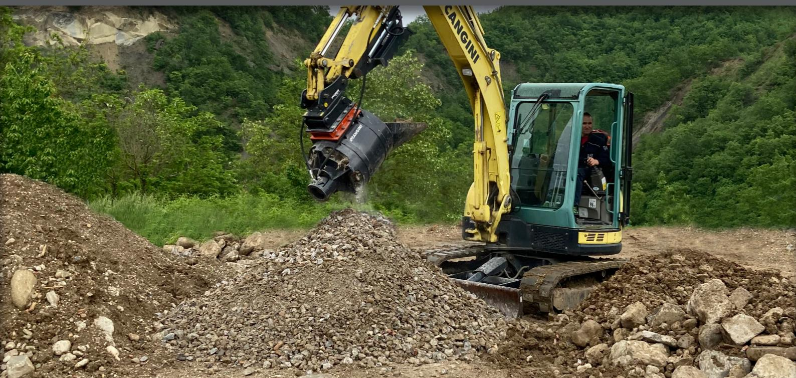
DER BACKENBRECHERLÖFFEL ERLEICHTET DIE AUFBEREITUNG UND DAS RECYCLING VON BAUSCHUTT UND KLEINVOLUMIGEM BAUSCHUTZ ZU VERWERTBAREN ZUSCHLAGSTOFFEN.
